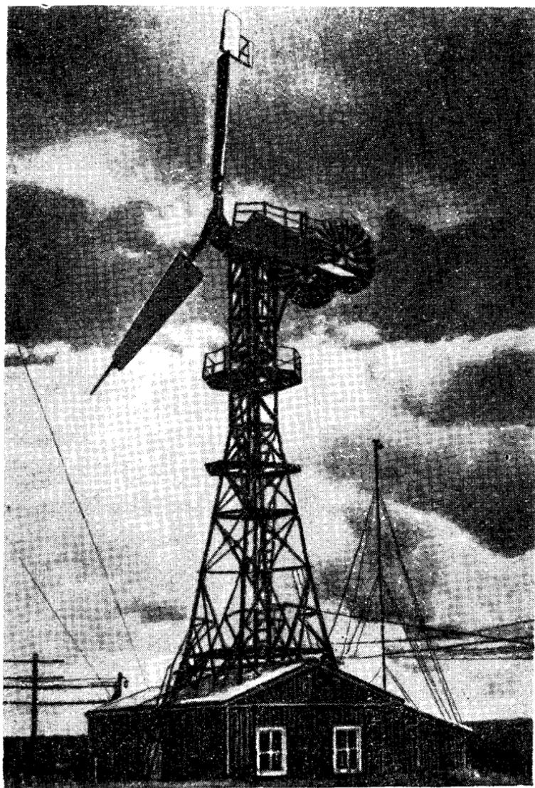
*Рис. 3.* Ветроэлектростанция Д-18.
